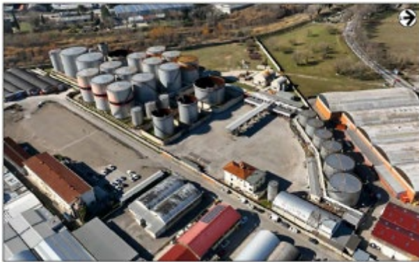
Figura 3. stato di fatto
